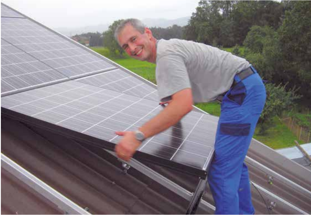
Christian Wolf montierte früher selber noch die Solarmodule auf den Dächern.
