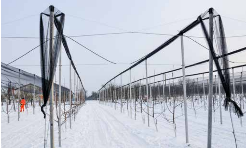
Auch im Winter werden Hagelnetze fleissig montiert.
